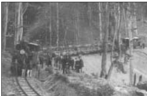
Slávnostné otvorenie úseku trate Mankovec - Stará Hora na jeseň 1914
